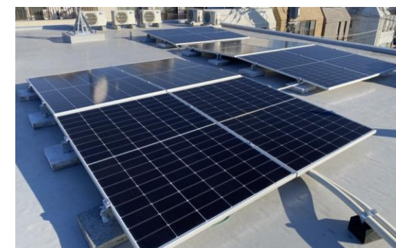
※東京都中野区 施工事例
